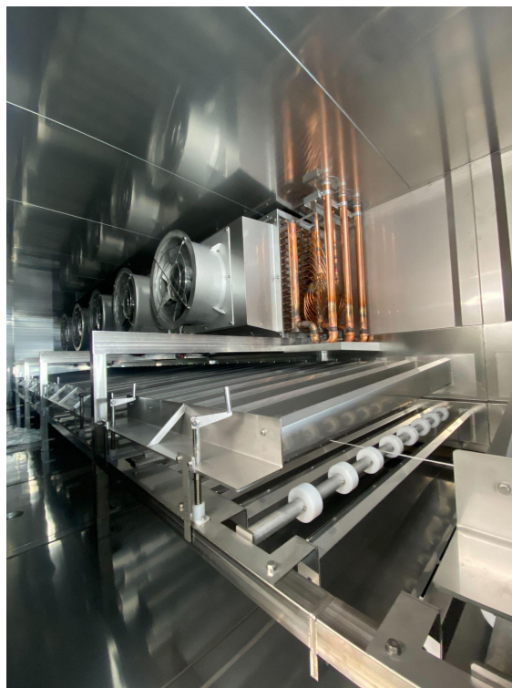
設置中のトンネルフリーザー（2023年12月末時点）
